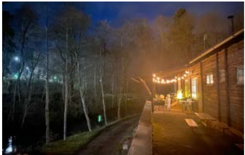
Sauna-ja pesularakennus, Jokisauna, Kauttuan Ruukinpuisto
